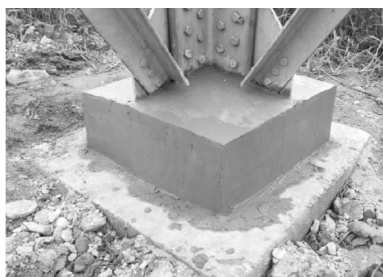
图2 输电铁塔地脚螺栓保护层
